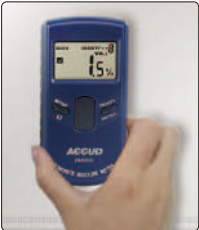
Duvar nem ölçümü
